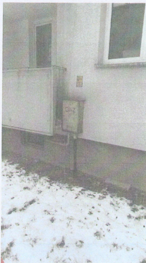
Miejsce lokalizacji pożarowego kurka głównego gazu- tylna, zewnętrzna elewacja obiektu na wysokości kotłowni gazowej
